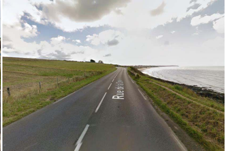
Passage actuel sur le côté droit : alternance de passages sur un petit talus et de passages complètement sur la route (comme près du mur)
