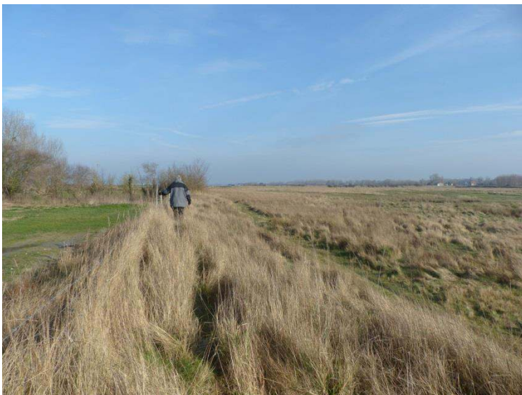
Tronçon DE : un débroussaillage du talus permettrait de cheminer plus en hauteur et donc plus au sec
