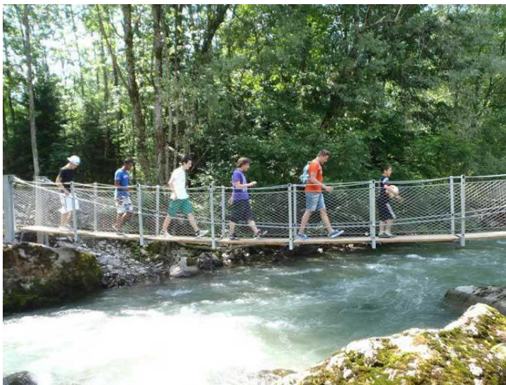
Référence passerelle souple type « pont de singe » avec tablier en lattes de bois et filets sur les côtés réalisée par l'entreprise Tech Fun (Saint Jean d'Aulps, 74)
