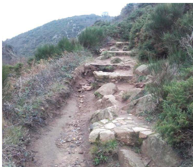
Quelques passages dégradés du sentier
