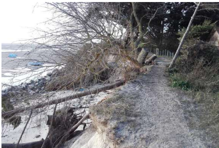
L'érosion rapide du trait de côte engendre sans relâche la disparition du sentier et des chutes d'arbres
