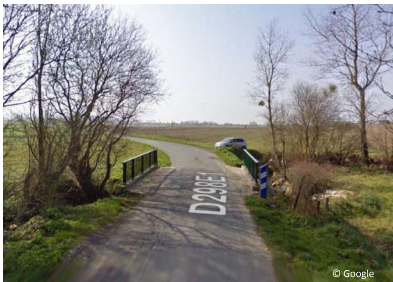
La RD 298 Et est la seule route avec un pont permettant de franchir le Ruet
