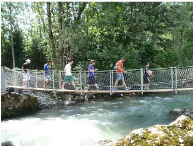
Référence passerelle souple type « pont de singe » avec tablier en lattes de bois et filets sur les côtés réalisée par l'entreprise Tech Fun (Saint Jean d'Aulps, 74)
