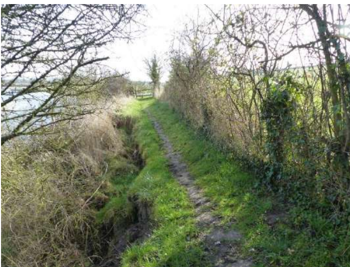
Tronçon BC : sentier très érodé par le méandre de la Sienne devant les parcelles ZC 31, 32 et 33
