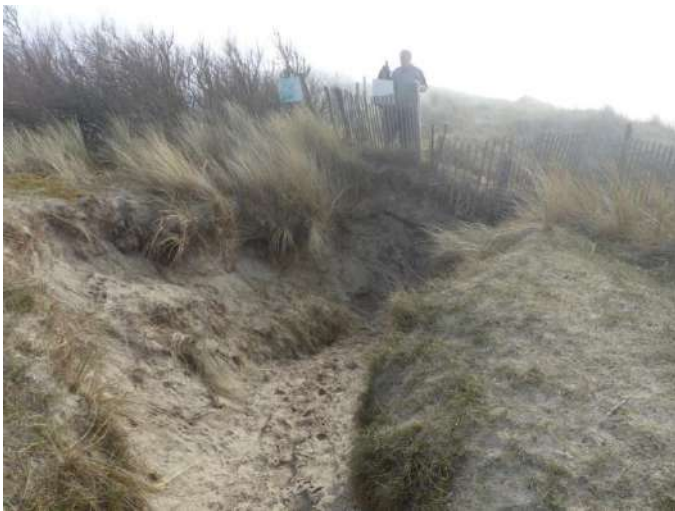
Tronçon AB : colmatage de la brèche créée par le passage des promeneurs
