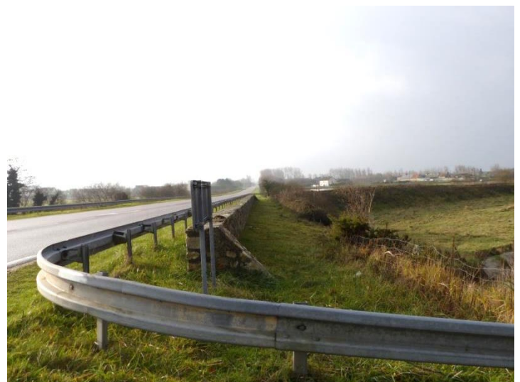
Tronçon BC : cheminement sécurisé derrière la glissière de sécurité et le mur en pierre
