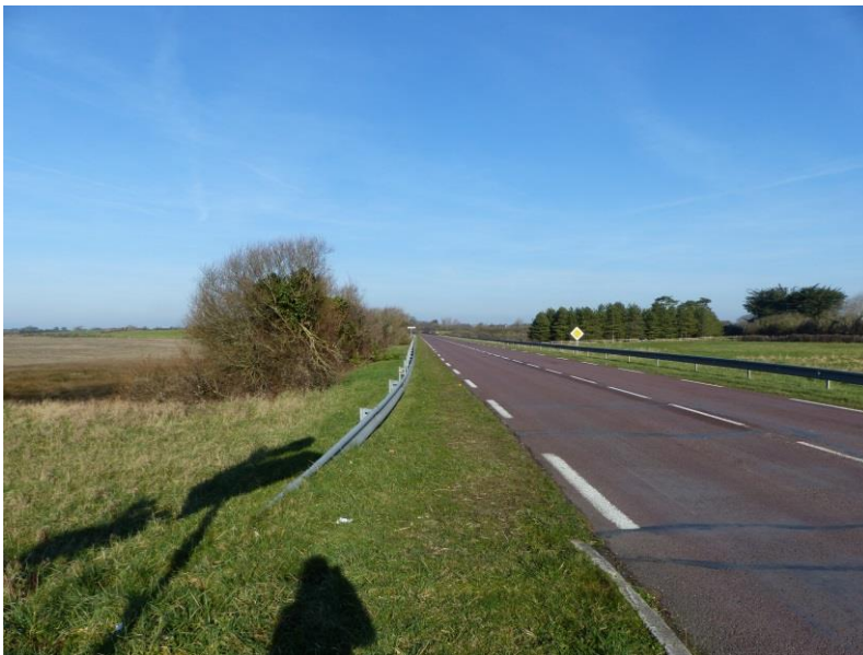
Actuellement, la largeur de l'accotement et les branches d'arbres ne permettent pas de rester derrière la glissière de sécurité
