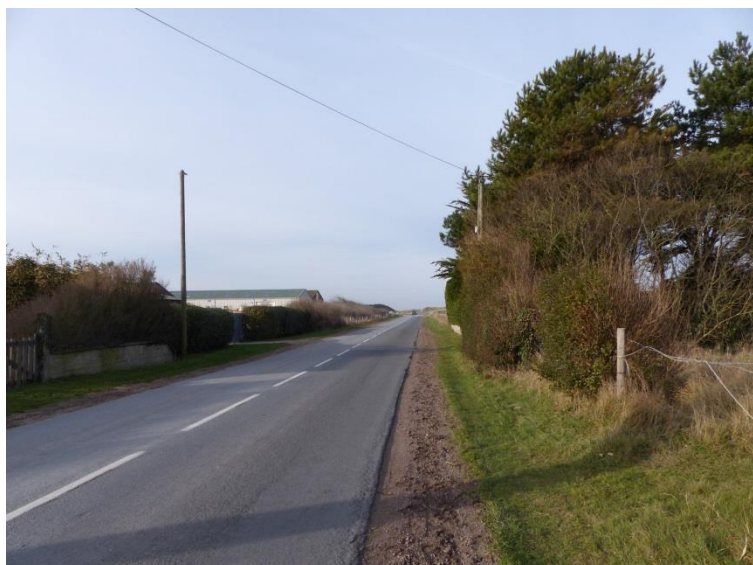
Le GR® 223 passe actuellement 1 250 mètres sur la RD 421, route très fréquentée
