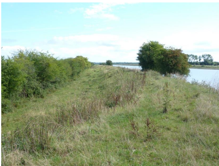
Tronçon bc : digue privée pâturée sur laquelle le cheminement des randonneurs nécessiterait la mise en place de clôtures
