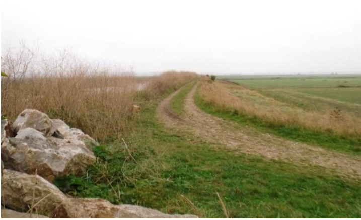
Tronçon bc : un chemin en terre existe déjà tout le long des polders privés
