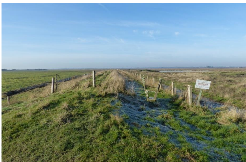
Digue du polder Petit Saint-André : tous les passages d'homme sont à remplacer
