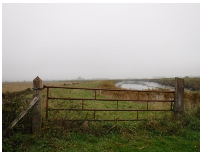
Barrière sur la digue côté écluse du port
