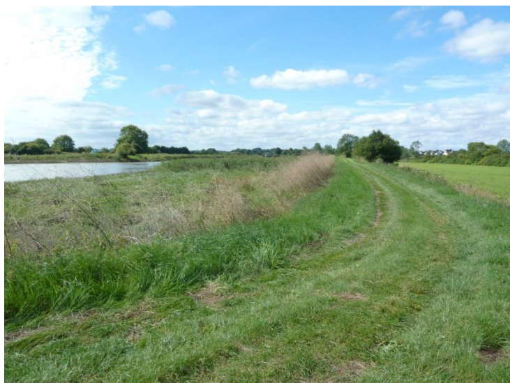
Tronçon ab : digue/chemin appartenant au Syndicat de la Vire et du Saint-Lois (SVSL)
